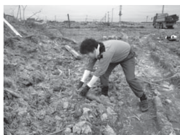
▲がれきの撤去作業をする尾崎大介都議
